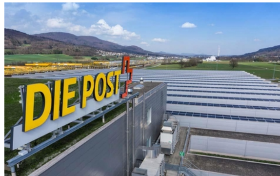
Unterhalt Briefverteilzentrum Härkingen
