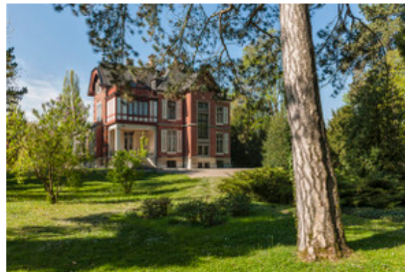
Einbau einer privaten Primarschule in eine alte Villa
