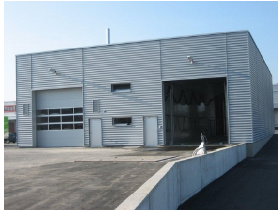
Installation von neuem Servicegebäude mit automatischer Waschstrasse.
