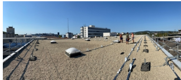
Lösung für schlechte Verbaubarkeit im Randbereich
