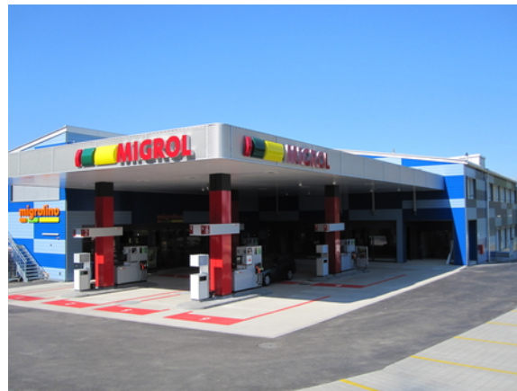
Geschäftshaus mit Tankstelle
