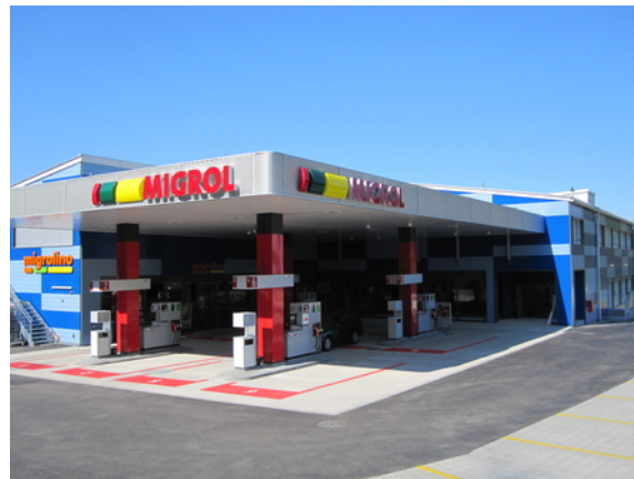
Geschäftshaus mit Tankstelle
