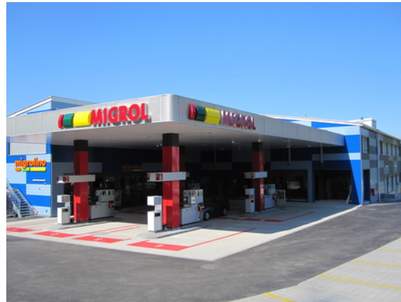
Geschäftshaus mit Tankstelle
