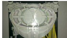
Spleisskassette in einem
