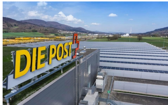
Unterhalt Briefverteilzentrum Härkingen
