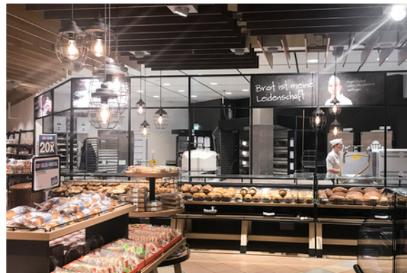
Sanierung Migros Wettingen
