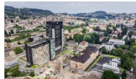
Kantonsspital St. Gallen, Areal
