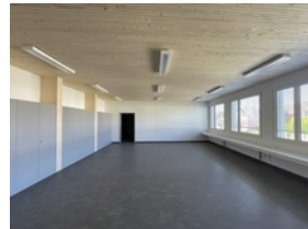
Fertige Inst. Schulzimmer
