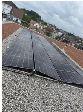
Inst. PV-Anlage
