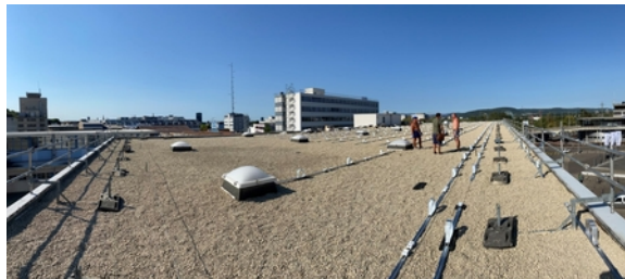
Solution à une pose difficile en périphérie du toit
