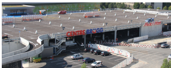
Vue du parking
