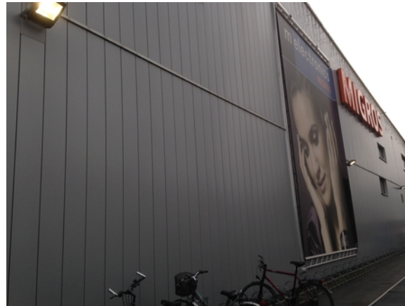
Vue du parking
