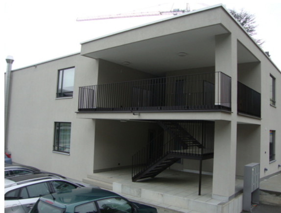
Construction de l'immeuble locatif au Schlossbergweg
