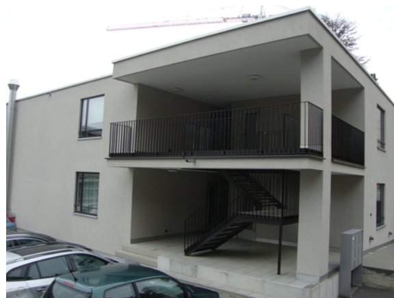
Construction de l'immeuble locatif au Schlossbergweg
