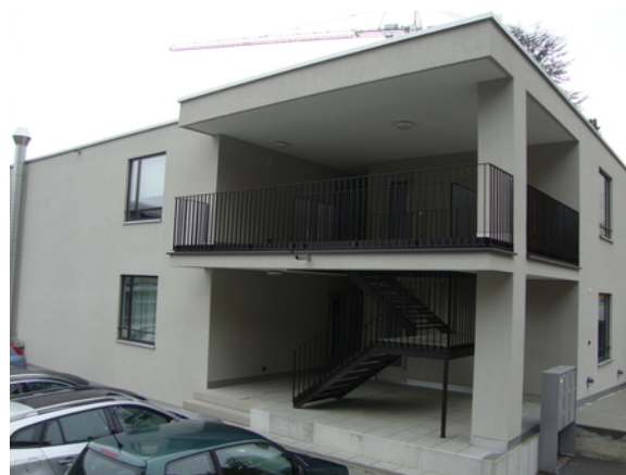
Construction de l'immeuble locatif au Schlossbergweg
