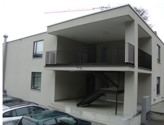
Construction de l'immeuble locatif au Schlossbergweg
