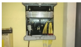
BEP (Building Entry Point) « Boîtier de distribution », regroupement du câble Access avec le câble Inhouse
