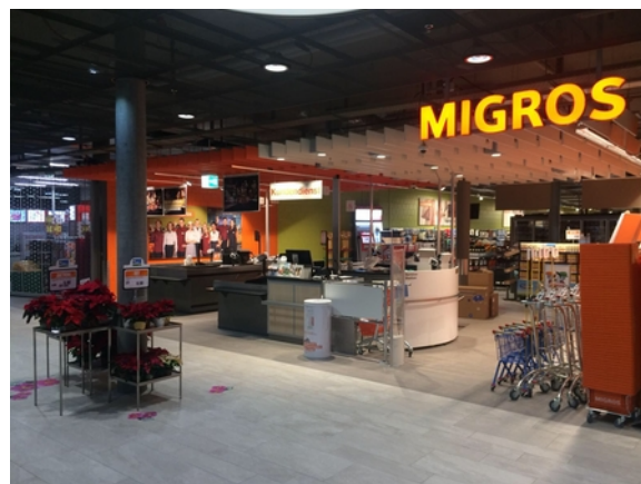
Nouveau bâtiment Migros Suhr
