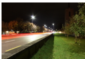
Assainissement Seestrasse Horn
