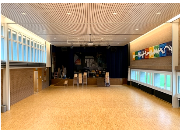
Rénovation de l'éclairage
