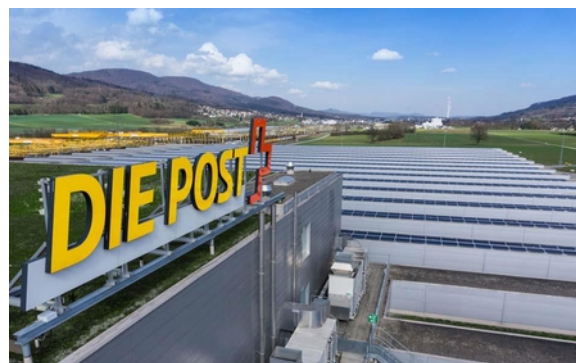
Lavori di mantenimento del centro corrispondenza di Härkingen
