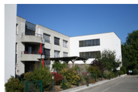
Residenza St. Martin - Estensione
