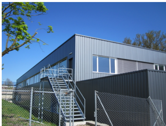
Edificio annesso degli uffici
