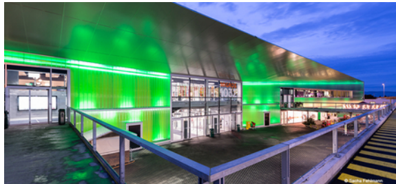
Centro commerciale Migros Romanel
