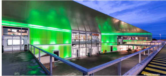
Centro commerciale Migros Romanel
