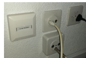
Basetta terminali per fibra
