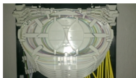
Basetta terminali per fibra
