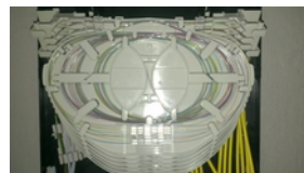
Basetta terminali per fibra
