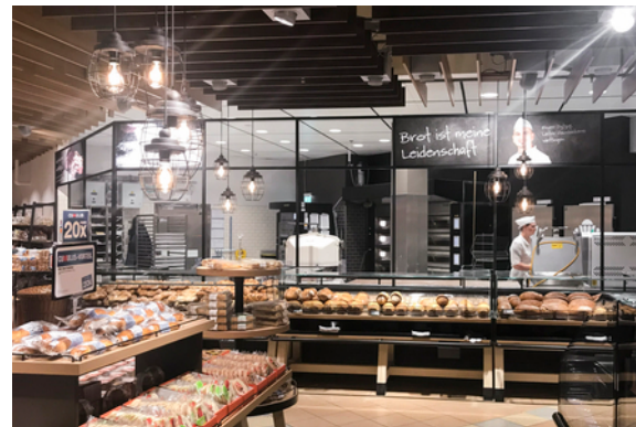
Ristrutturazione Migros Wettingen
