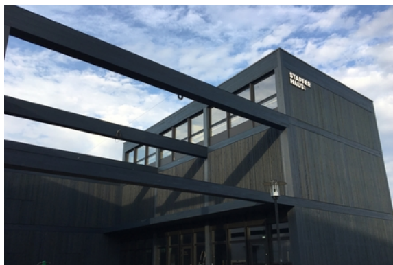
Edificio di esposizioni
