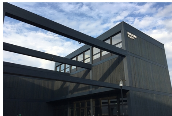
Edificio di esposizioni
