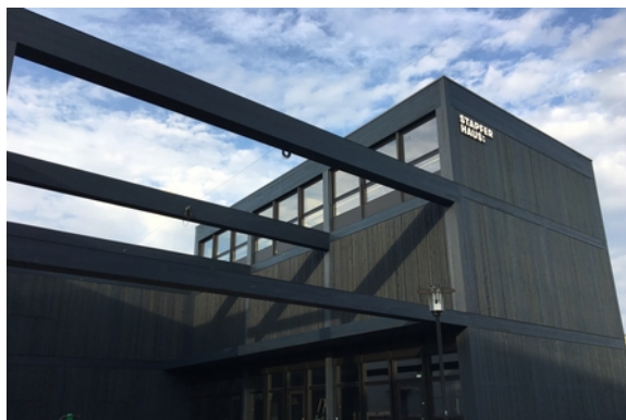
Edificio di esposizioni
