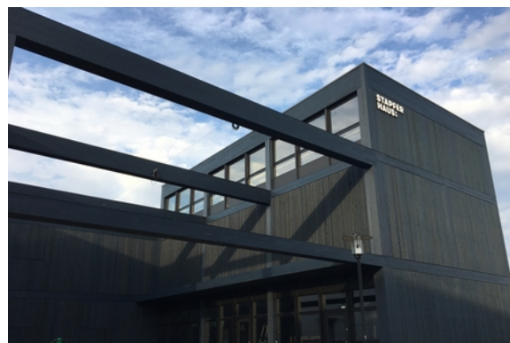
Edificio di esposizioni
