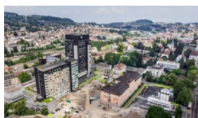
Kantonsspital St. Gallen, Areal
