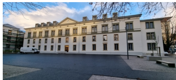
L'edificio scolastico Dufour
